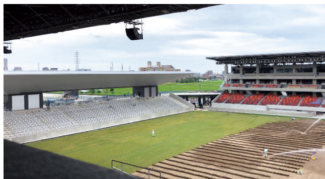
ピッチ施工状況
