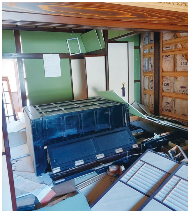
実家の内部状況
