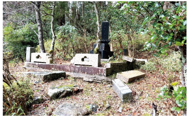
庭:[墓地]:御影石の壁4段積倒壊
