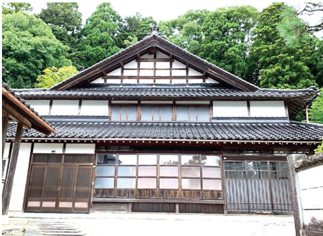
左図：古民家（正面：松平邸宅）
