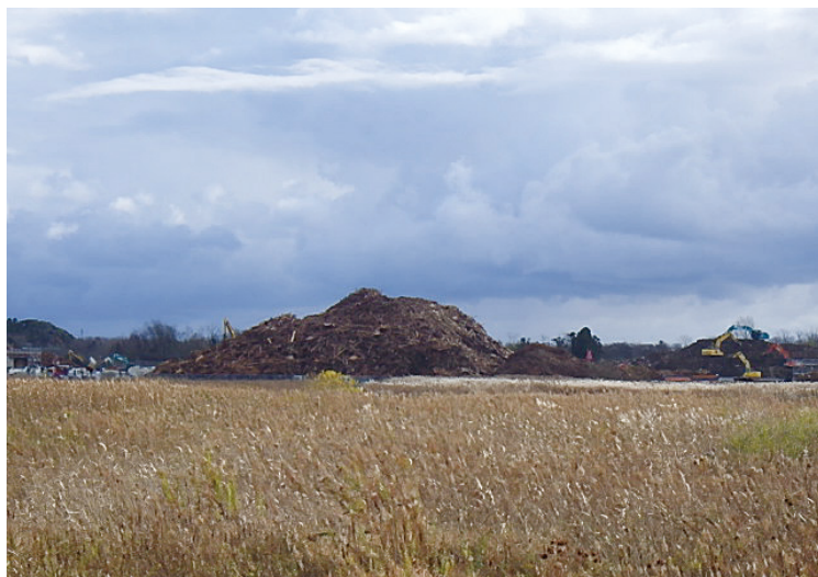
建物解体処分場蛸島町地内
