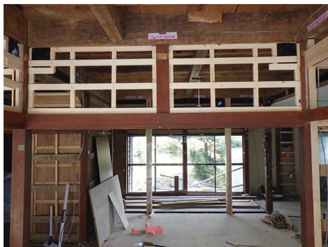
復興に向け耐震補強工事を開始
